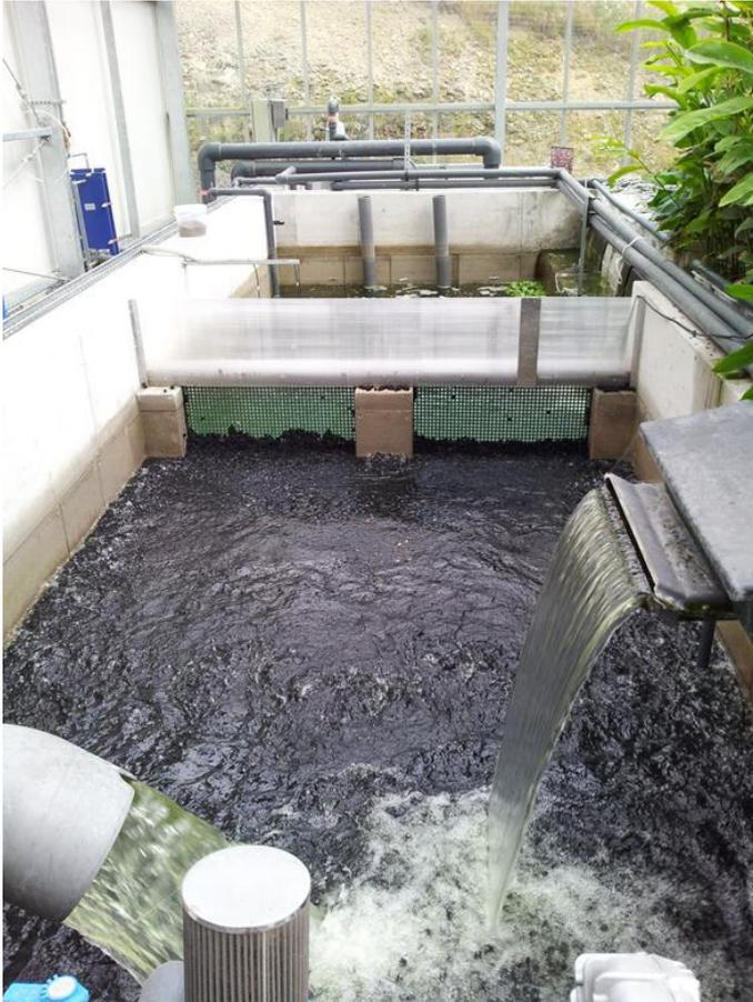
***Biofilteranlage der Aquakultur (unten Biofilterbecken; oben Pumpensumpf)***
