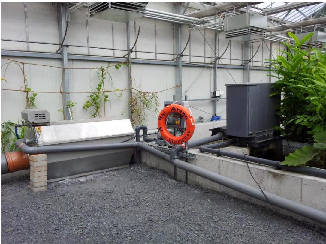
***Filteranlage der Aquakultur (links Trommelfilter; rechts Protein-Skimmer)***
